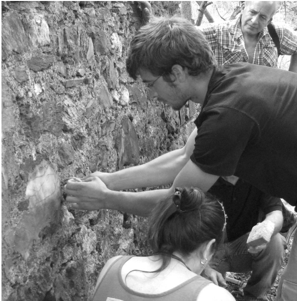
Taller de neteja de mur de pedra
