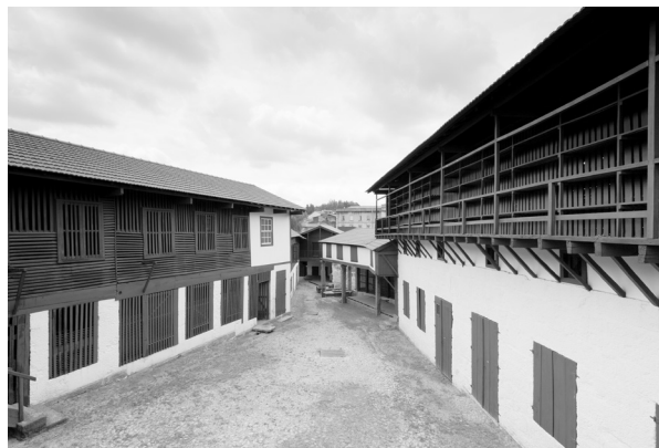
Figura 7. Antigua fábrica de curtidos Âncora, convertida en centro educativo (2007-2011). Foto: Luís Ferreira Alves, CMG, 2011
