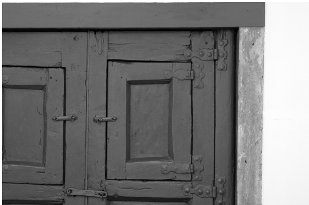
Figura 5. Detalle de las carpinterías en la Casa da Rua Nova. Foto: Ricardo Rodríguez, 2014
