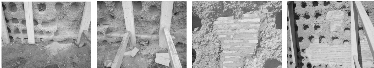
Figura 3. Procés constructiu. Consolidació del mur de tàpia amb obra de maó massís i morter de calç. Fotografies: Marilena Gracia Suñé, José Luis Sanz Botey, arxiu SPAL
