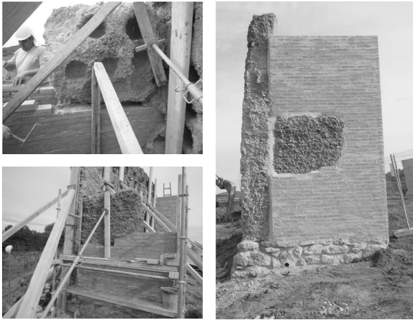
Figura 4. Contrafort de ponent. Recuperació d'un fragment de tàpia. Fotografies: Marilena Gracia Suñé, José Luis Sanz Botey, arxiu SPAL
