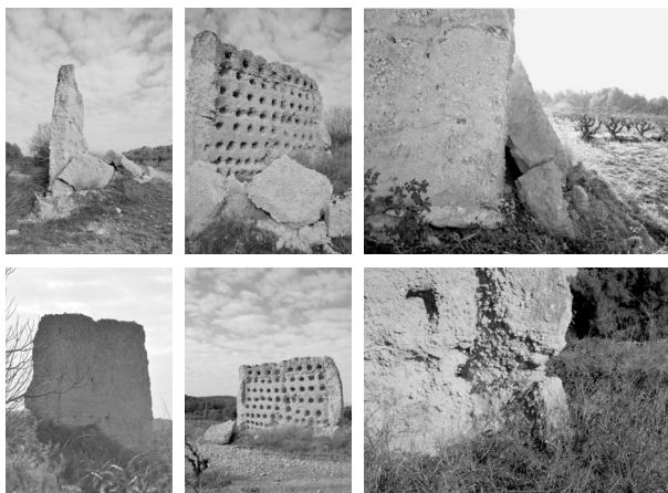
Figura 1. Diversos aspectes de l'estat inicial. Fotografies: Rosa Escala i José Luis Sanz Botey, novembre 2011. Arxiu SPAL
