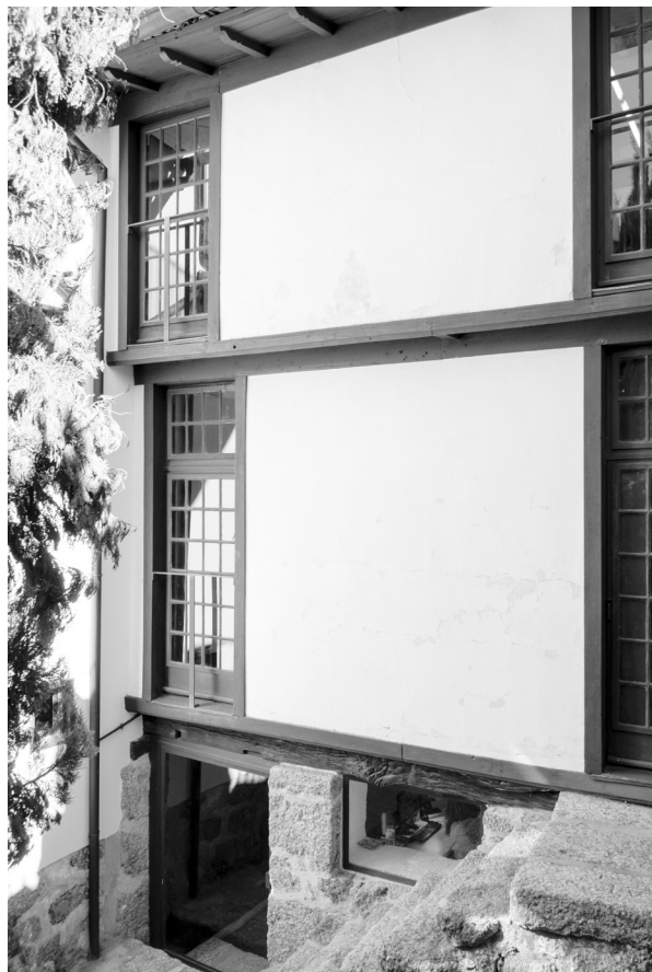
Figura 4. Fachada posterior de la Casa da Rua Nova.
