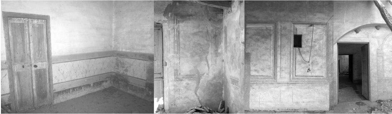
Elements decoratius d'espais interiors i de la galeria de la masia (2013)
