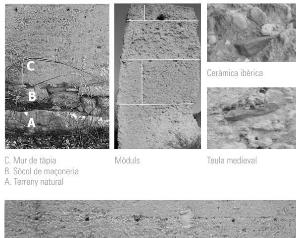
Encaix de les agulles de l'encofrat
